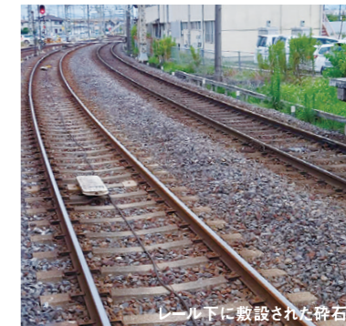
レール下に敷設された碎石
