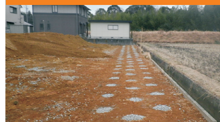
[施工場所] 三重県 [施工数量] 1.75m×156本
