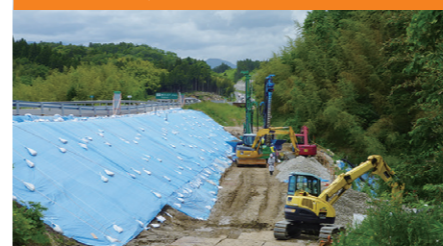
[施工場所] 宮城県 [施工数量] 5m×200本
