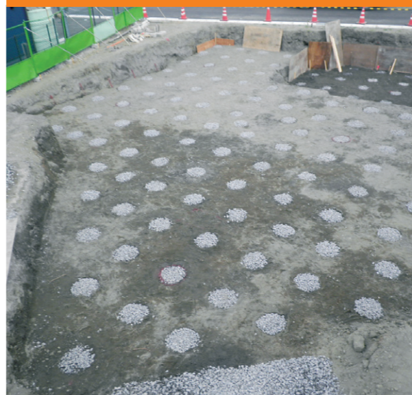
[施工場所] 千葉県 [施工数量] 4.5m×171本
