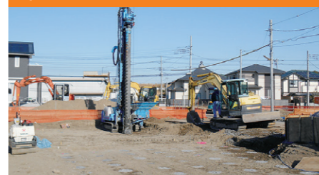
[施工場所] 千葉県 [施工数量] 4m×750本
