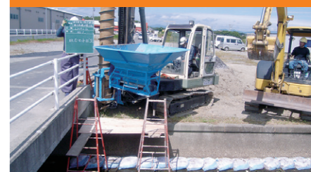
[施工場所] 三重県 [施工数量] 3~3.5m×20本
