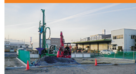
[施工場所] 三重県 [施工数量] 2.25m×51本
