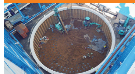
[施工場所] 埼玉県 [施工数量] 4.76m×292本
